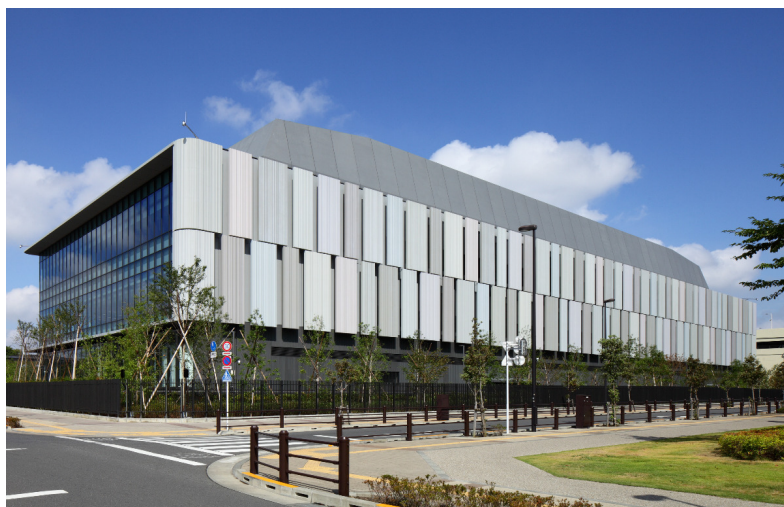
キャノンITS 西東京データセンター
