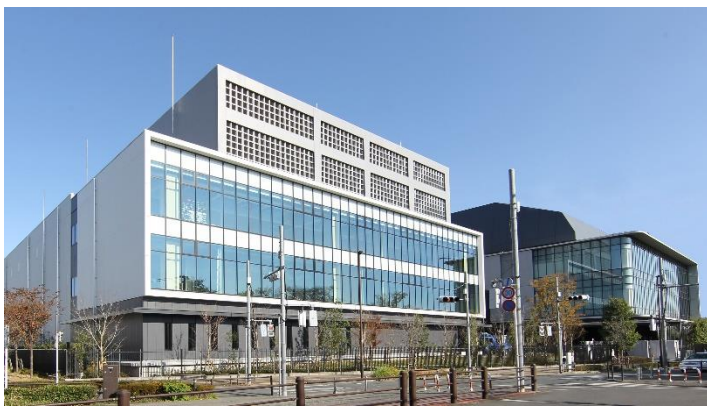
西東京データセンター
