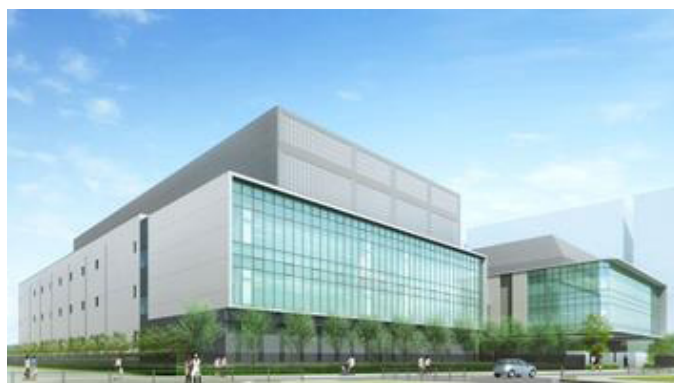
西東京データセンター 2号棟
