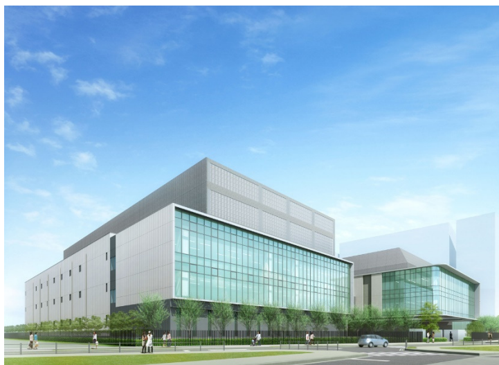
キヤノンITS 西東京データセンター新棟
