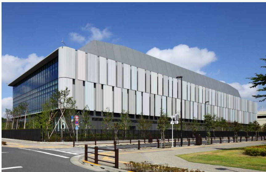
＜西東京データセンター＞
